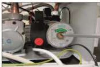
2. Отвинтите центральный винт с помощью отвертки
