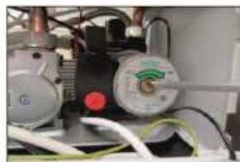
5. Закрутите обратно центральный винт (2,5 Нм) и закройте лицевую панель котла
