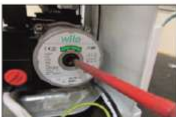
4. Используя отвертку, проверните ротор влево и вправо
