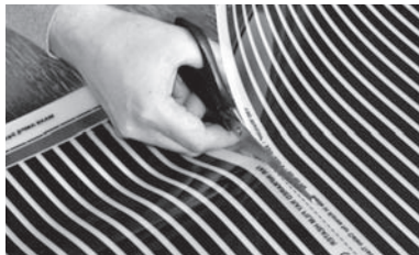
Рис. 4. Разрезание термопленки CALEO по линиям отреза
