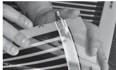
Рис. 5. Установленный на термопленку контактный зажим
